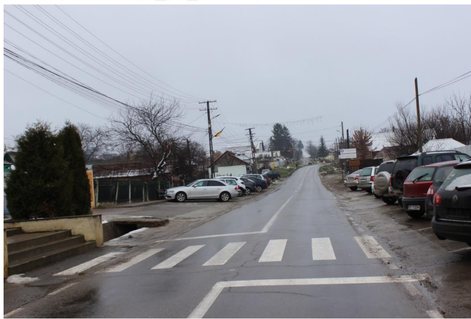
Drum principal (în fața Primăriei) – sat Ion Creangă, comuna Ion Creangă
