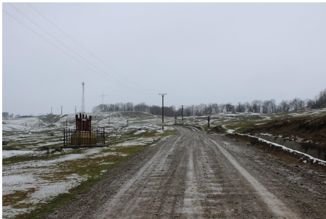
Drum spre satul Muncelu, comuna Ion Creangă
