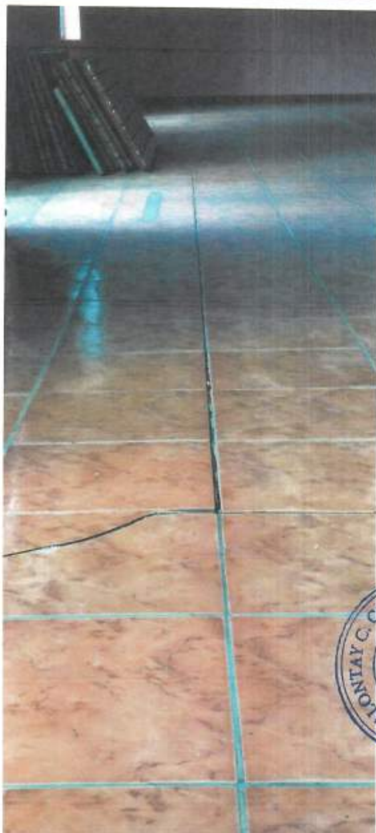
Foto 20 – fractură longitudinală în rostul gresiei din cauza poansonării pardoselii și a tasării fundațiilor
