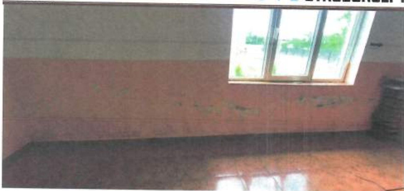
Foto 15 – infiltrații la pereții exteriori
