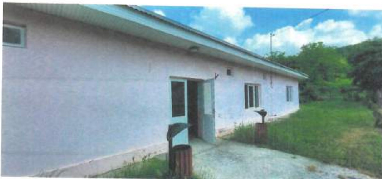
Foto 3 – fațada principală, intrarea în cămin
