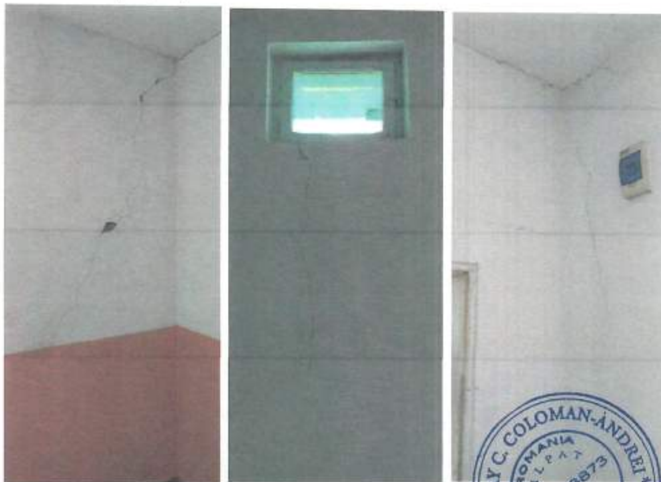
Foto 15 – infiltrații la pereții exteriori
