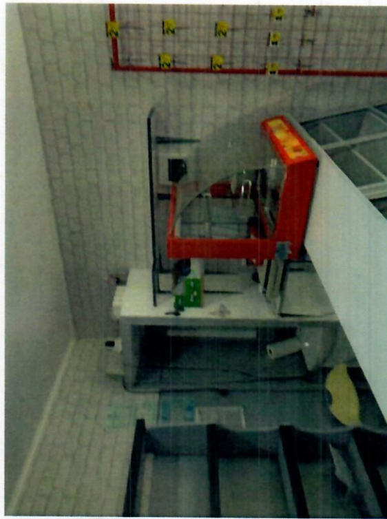
Foto 7: Detaliu finisaj interior chiosc.
